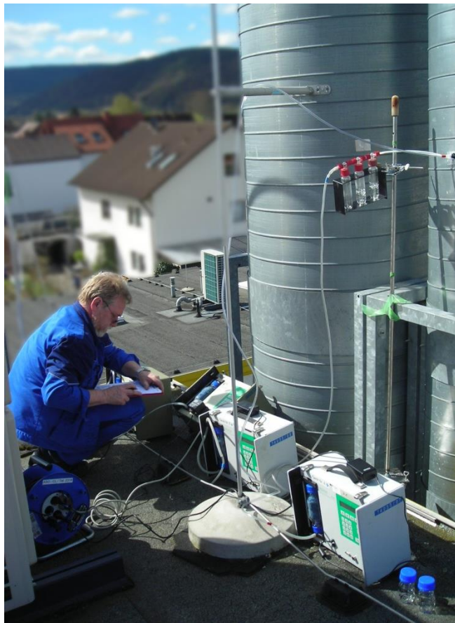
Abbildung 1: Mitarbeiter von ASO-CL bei der Messung gasförmiger Emissionen.
